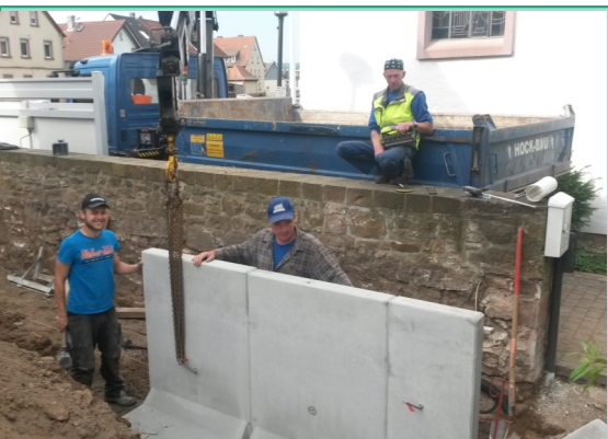
Die Errichtung des barrierefreien Zugangs (Foto: Regina Krebs)
