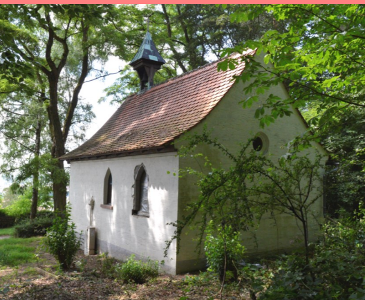
Die neuen Fenster sind schon angelegt.
