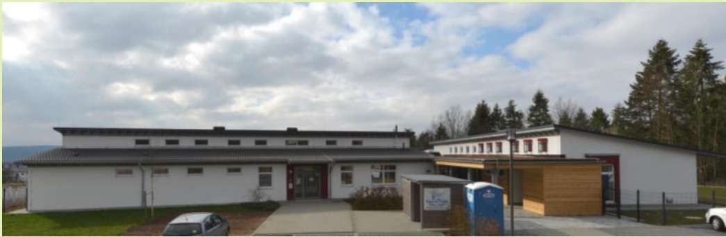
Links der erste und rechts der neue Baukörper der Kinderkrippe Sonnenhügel (Foto: Manfred Kiesel)
