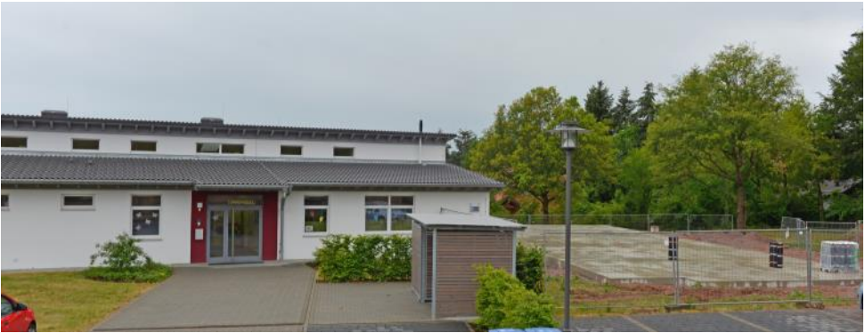
Kinderkrippe Sonnenhügel mit der inzwischen betonierten Bodenplatte für den Erweiterungsbau (Foto: Susanne Kiesel)
